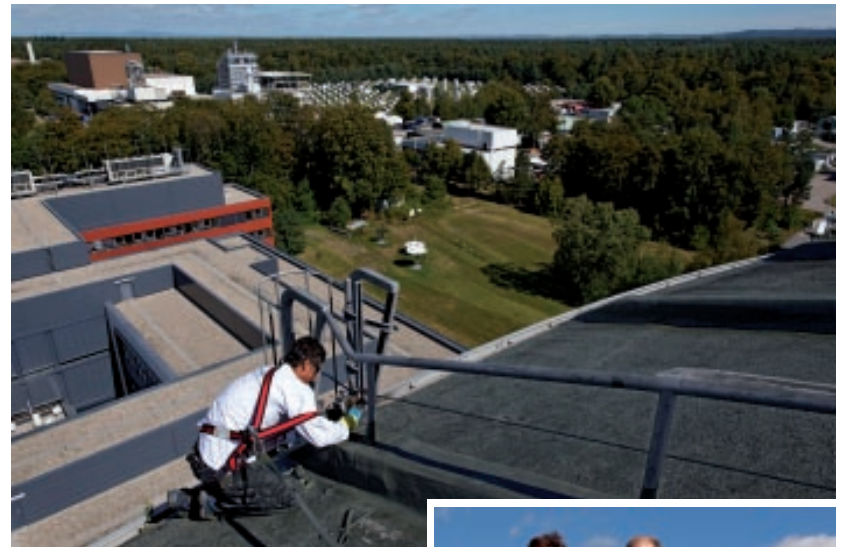
Alle Arbeiten erfolgten in 34 Meter Höhe. Darum mussten die Dachdecker permanent mit persönlicher Schutzausrüstung arbeiten.
