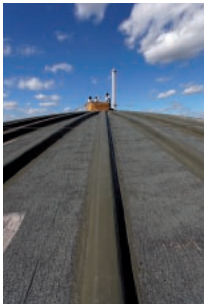
Zunächst wurden alle Stahlzüge abgedichtet.
