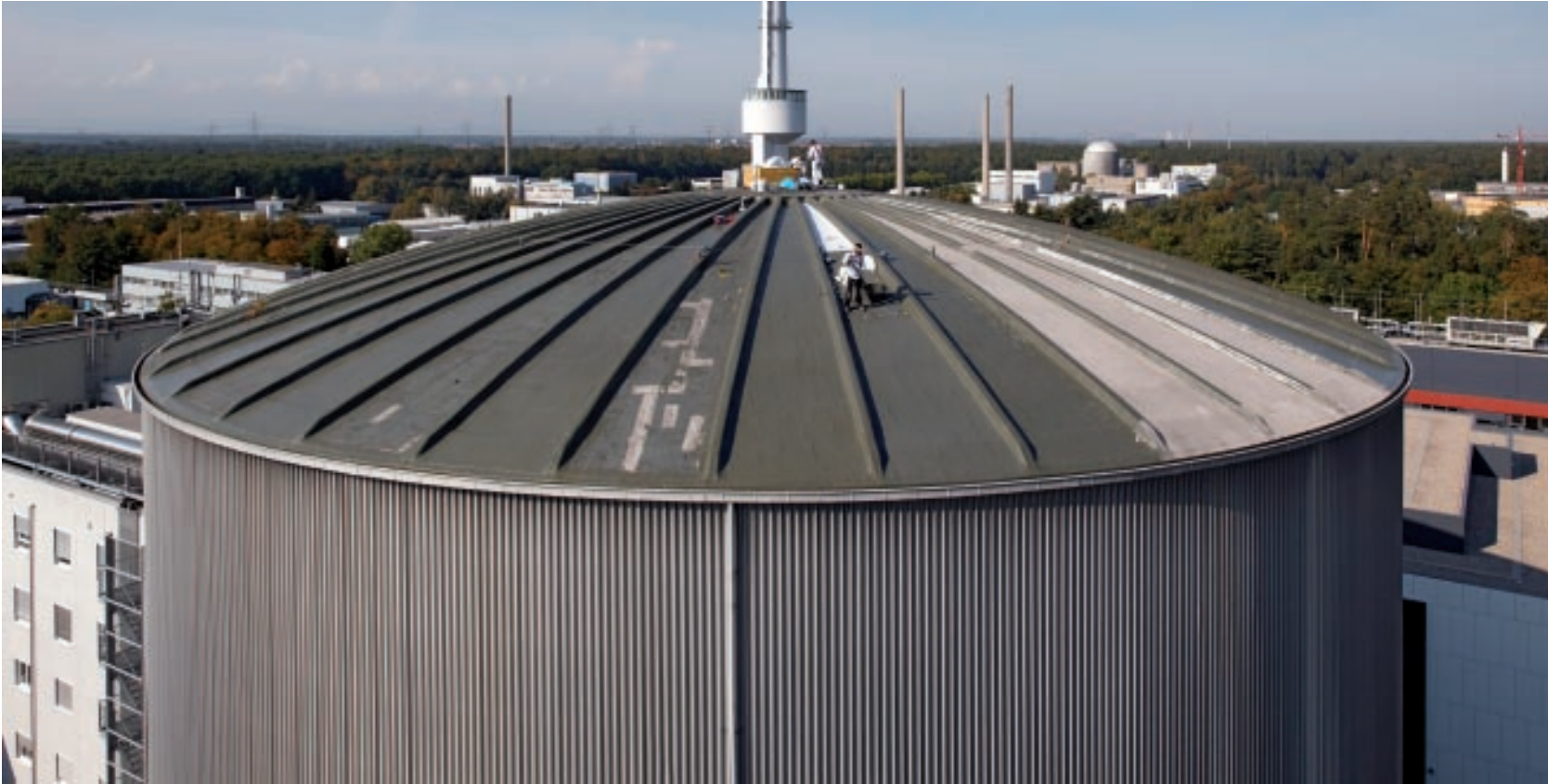
Blick von oben auf das Dach während der Abdichtungsphase.
