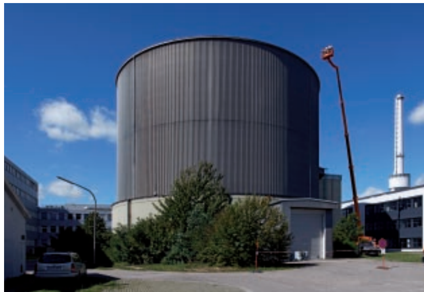
Unter Schutz gestellt: In 34 Metern Höhe sichert die KEMPEROL® 2K-PUR Abdichtung das Dach des Forschungsreaktors 2 in Karlsruhe.
